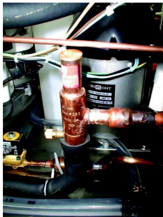
5 Valvola di regolazione della pressione di evaporazione costante (Danfoss KVP 12 nel MF 58 e Danfoss KVP 22 nel MF 68)
